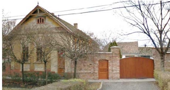
Kálvin János tér 4. lakóház hrsz 141 Kapuja, kerítése is védendő!
