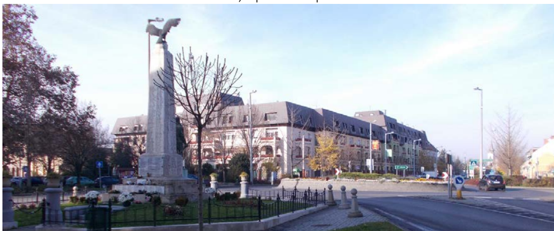
A Fő úton, a kastélyal szemben 3-4 szintes, két szint magas tetőtérbeépítés épület áll.
