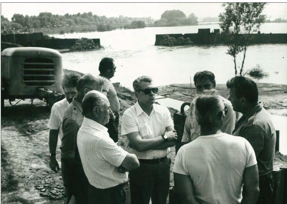
Helyszíni szemle az 1980-as Hosszúfoki töltésszakadásnál
